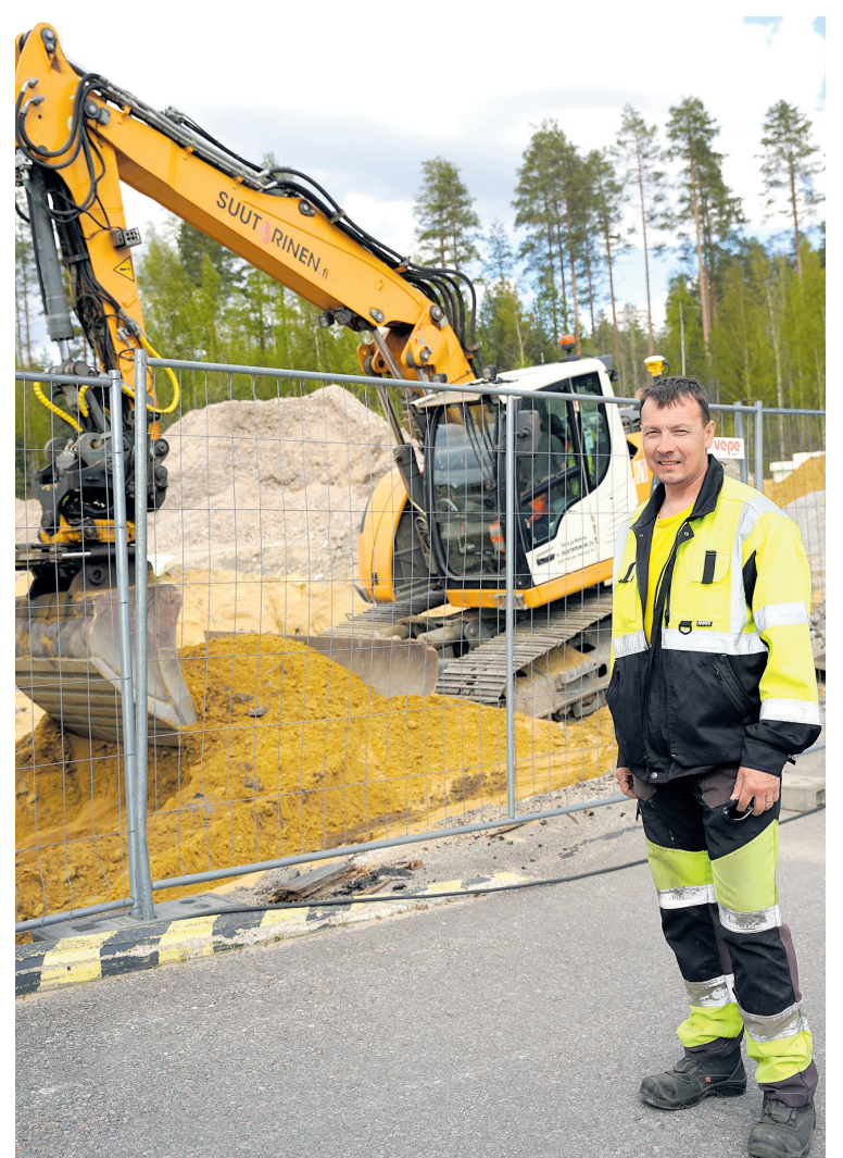
Itsepalveluaseman tuleva vastuuhenkilö Petteri Huttunen on tyytyväinen rakennustöiden etenemiseen. – Projektin suuruus konkretisoituu rakennustyömaata katsoessa, hän sanoo.
